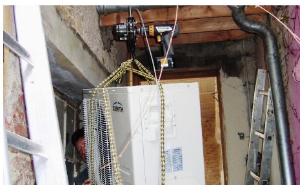
Levage de charges diverses (matériaux...) sur un chantier.
